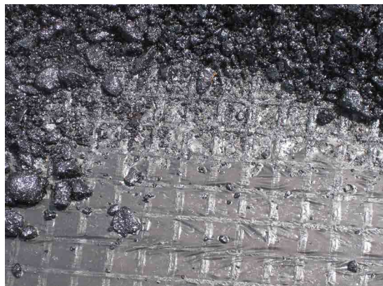
Obr. 7: Natavení filmu pro spojení vrstev
