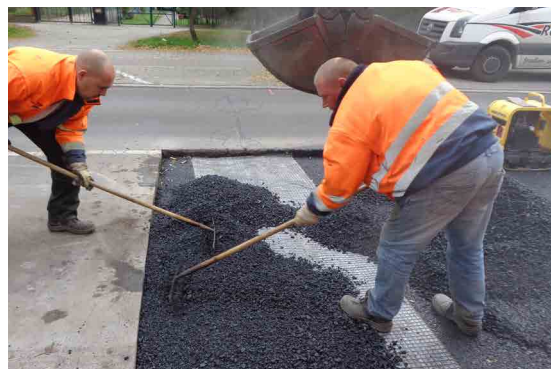
Obr. 9: Pokládka asfaltové vrstvy na mříž ADFORS GlasGrid PG
