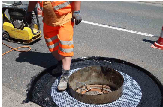
Obr. 4: Instalace mříže ADFORS GlasGrid PM pro ochranu šachet
