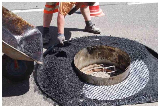
Obr. 8: Pokládka asfaltové vrstvy na mříž ADFORS GlasGrid PM
