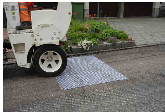
Obr. 3: Instalace mříže ADFORS GlasGrid PG pro lokální sanace a aktivace adhezní složky
