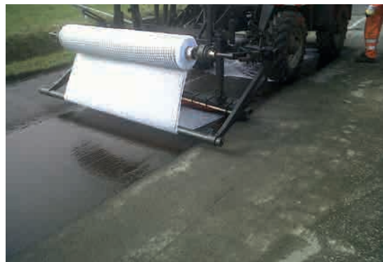
Obr. 4: Mechanická instalace geokompozitu ADFORS GlasGrid CGL
