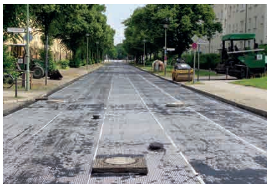
Obr. 2: Typická instalace geomříže ADFORS GlasGrid CG/CGL na frézovaný povrch
