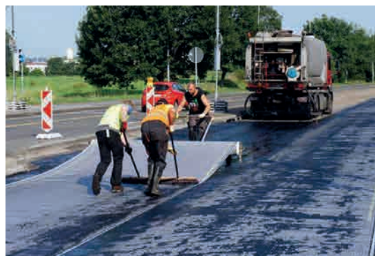
Obr. 5: Manuální instalace geokompozitu ADFORS GlasGrid CGL
