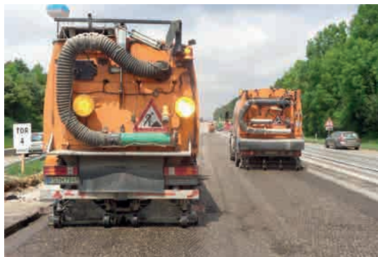
Obr. 1: Vysokotlaká technologie pro čištění povrchu
