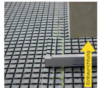
**Abb. 6:** Längsüberlappung von Gitterenden
