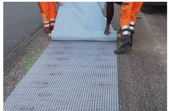
Abb. 2: Reparatur lokaler Schadstellen mit ADFORS GlasGrid PG
