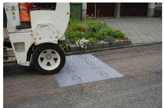
Abb. 3: Aktivierung der selbstklebenden Eigenschaften von ADFORS GlasGrid PG durch Anwalzen
