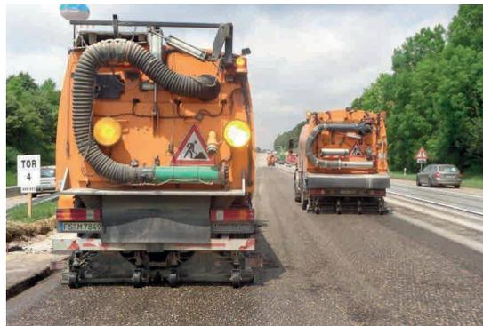
**Abb.1:** Wasserhochdrucktechnologie zur optimalen Reinigung der Asphaltoberfläche
