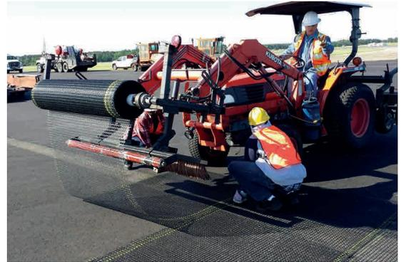
**Abb. 3:** Maschinelle Installation von ADFORS GlasGrid GG
