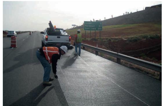
**Abb. 4:** Manueller Handeinbau von ADFORS GlasGrid GG
