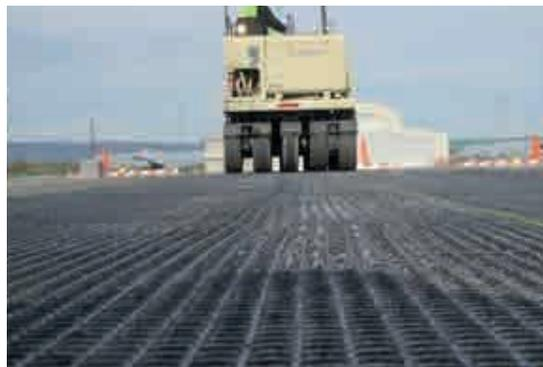
**Abb. 2:** ADFORS GlasGrid GG - Installation, Aktivierung des selbstklebenden Effektes durch gummibereifte Walze.
