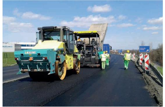
**Abb. 9:** Deckschichteinbau
