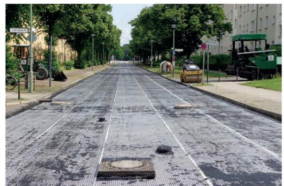
**Abb. 2:** Typische ADFORS GlasGrid CGL/ CG Verlegung auf gefräster Oberfläche (optimal durchtränktes Gitter)
