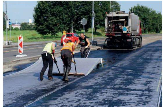
Abb. 5: Manuelle Verlegung ADFORS GlasGrid CGL
