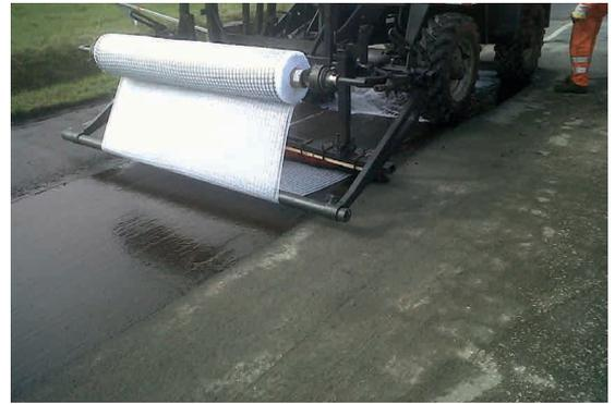
Abb. 4: Maschinelle Verlegung ADFORS GlasGrid CGL
