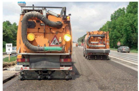
**Abb.1:** Wasserhochdrucktechnologie zur optimalen Reinigung der Asphaltoberfläche
