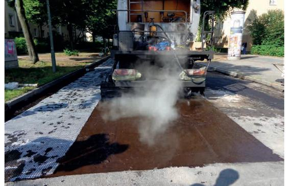
**Abb. 3:** Haftschichtauftrag vor ADFORS GlasGrid CGL Verlegung
