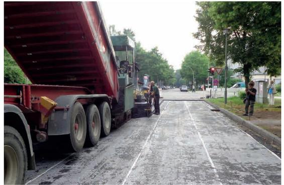
**Abb. 9:** Deckschichteinbau
