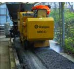
Im Test wurde ein extra starkes Glasfasergitter mit 200kN Zugfestigkeit auf einer existierenden Asphaltbinderschicht installiert und mit einer 4 cm starken Asphaltdeckschicht überbaut. Während des Fräsprozesses kam es zu keinen Beeinträchtigungen und die Fräswalze zeigte keine Auffälligkeiten (anhaftende oder verfangene Fasern).
