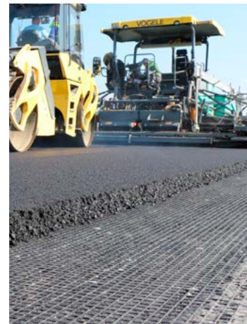
Instalace samolepicí geomříže ADFORS GlasGrid GG 100 na dálnici A1 Chirpan – Stará Zagora, 2021
