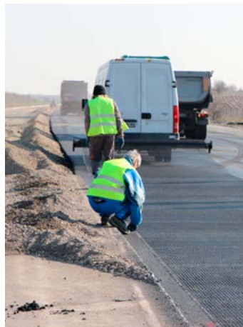
Instalace samolepicí geomříže ADFORS GlasGrid GG 100 na dálnici A1 Chirpan – Stará Zagora, 2021
