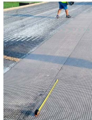
Instalace ADFORS GlasGrid Rapid Grid na nové dálnici, 2024
