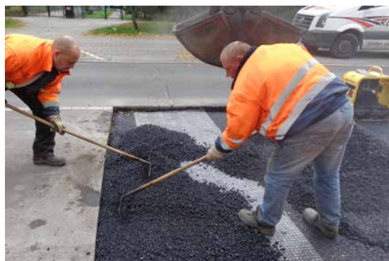
Image 18: Pose de la couche bitumineuse sur la grille ADFORS GlasGrid Rapid
