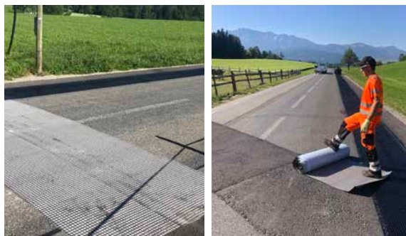
Images 10 - 11: Recouvrement des fissures réfléchives
