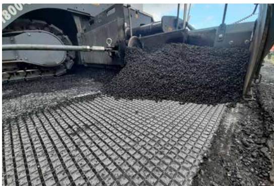
Image 17: La pose de la couche bitumineuse sur la grille ADFORS GlasGrid Rapid
