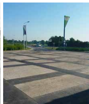
Image 13: Joints des panneaux en béton de ciment
