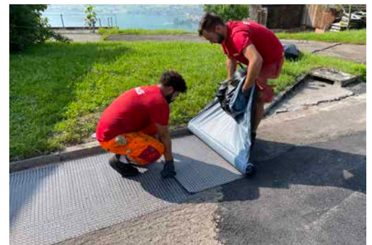
Image 2: Installation de la grille ADFORS GlasGrid Rapid pour les réparations localisées
