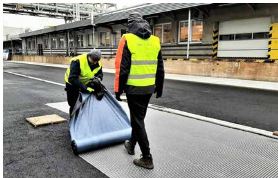
Image 4: Déroulez le renfort et retirez le film en une seule fois
