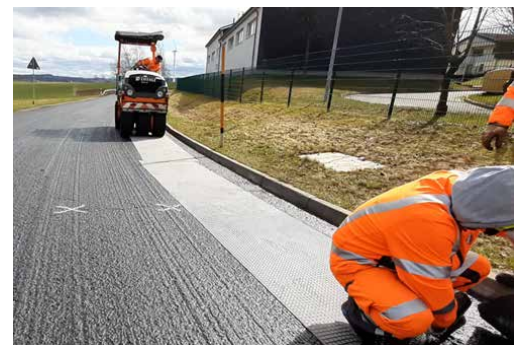
Image 3: Installation de la grille ADFORS GlasGrid Rapid pour les réparations de grandes surfaces
