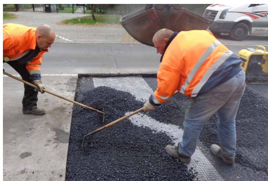
Obr. 16: Pokládka asfaltové vrstvy na mříž ADFORS GlasGrid Rapid
