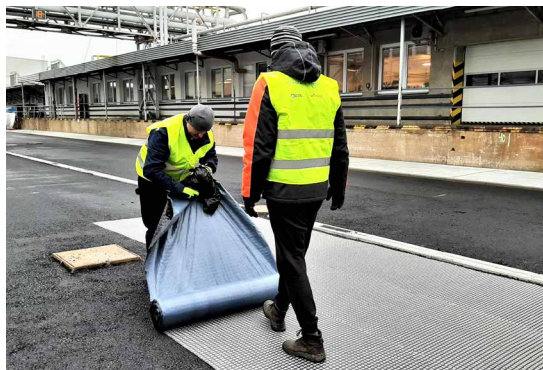
Obr. 2: Odrolujte výztuž a odstraňte fólii v jednom kroku
