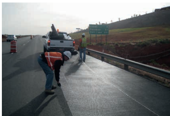
Obr. 4: Manuální instalace mříže ADFORS GlasGrid
