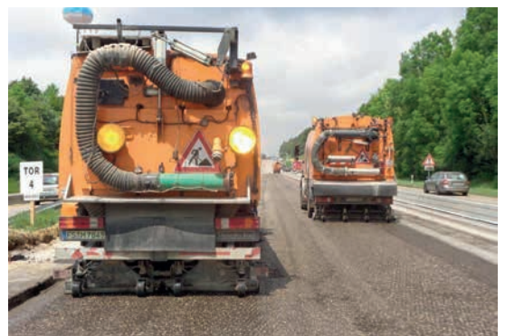
Obr. 1: Vysokotlaká technologie pro čištění povrchu
