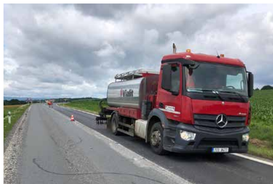
Obr. 8: Aplikace spojovacího postřiku na mříž ADFORS GlasGrid GG
