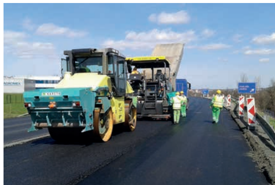
Obr. 9: Pokládka asfaltové vrstvy
