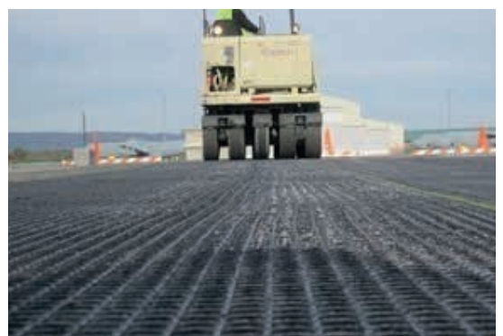
Obr. 2: Instalace a aktivace lepidla na vyrovnávací vrstvě
