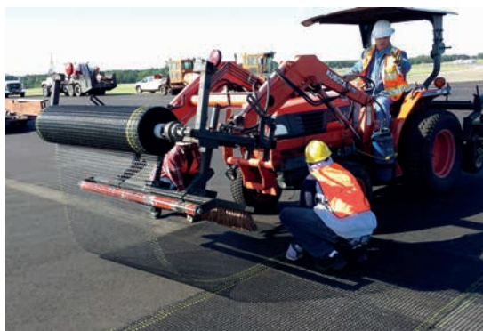
Obr. 3: Instalace mříže ADFORS GlasGrid mobilním zařízením
