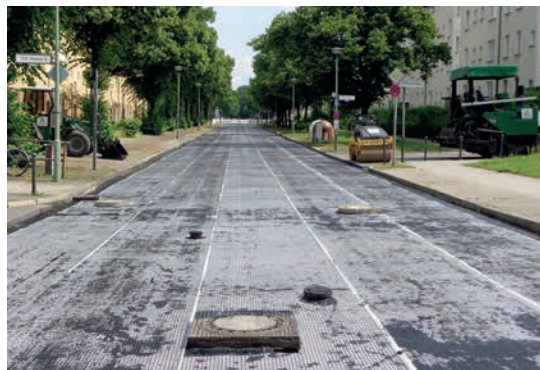
Obr. 2: Typická instalace geomříže ADFORS GlasGrid CG/CGL na frézovaný povrch
