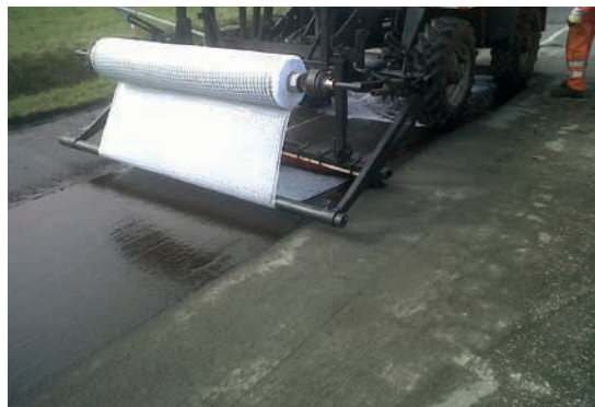
Obr. 4: Mechanická instalace geokompozitu ADFORS GlasGrid CGL
