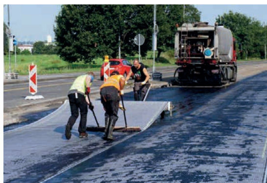
Obr. 5: Manuální instalace geokompozitu ADFORS GlasGrid CGL
