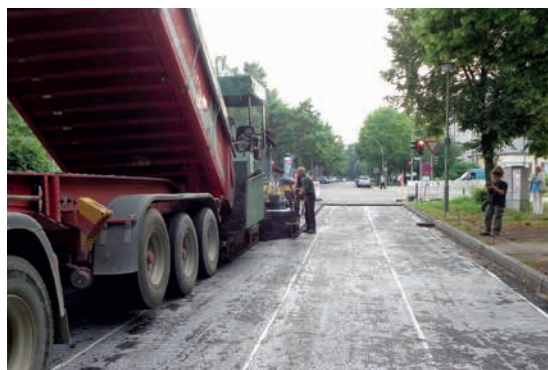
Obr. 9: Pokládka asfaltové vrstvy na geokompozit ADFORS GlasGrid CGL
