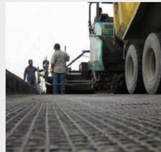
Installation d'ADFORS GlasGrid à l'aéroport d'Atatürk, 2010
