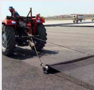
Installation d'ADFORS GlasGrid à l'aéroport d'Atatürk, 2010
