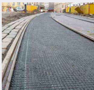
Installation d'ADFORS GlasGrid à Prague, 2013
