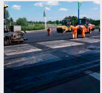
Einbau von ADFORS GlasGrid PG in Belgrad, 2018
