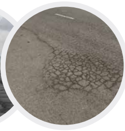
Schadensfall für vollflächige Verlegung
