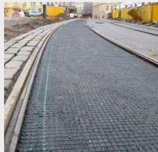
Einbau von ADFORS GlasGrid in Prag, 2013
