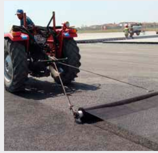
Einbau von ADFORS GlasGrid am Atatürk Airport, 2010
