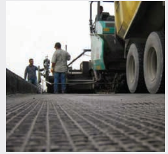
Einbau von ADFORS GlasGrid am Atatürk Airport, 2010
