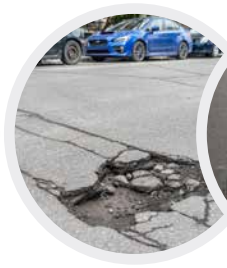
Příklad trhlin u lokálních oprav
