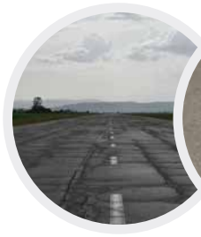
Příklad trhlin u velkoplošných oprav
