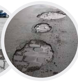
Příklad trhlin u lokálních oprav
