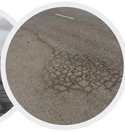
Příklad trhlin u velkoplošných oprav
