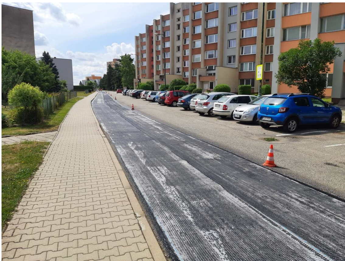
OBRÁZEK Č. 7 – POLOŽENÉ KOMPOZITNÍ MŘÍŽE, PŘÍPRAVA NA EMK
