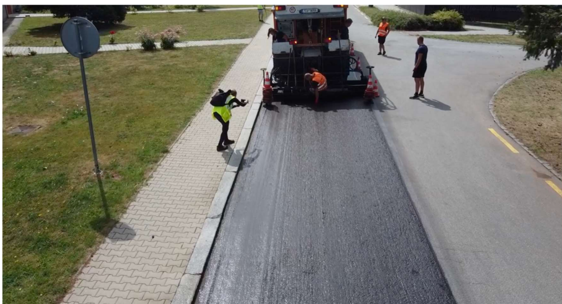
OBRÁZEK Č. 8 – POKLÁDKA PRVNÍ VRSTVY EMK
