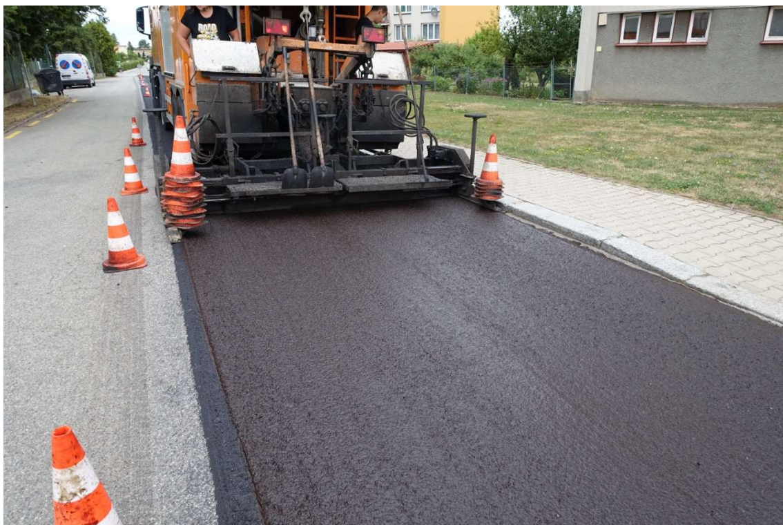
OBRÁZEK Č. 9 – POKLÁDKA DRUHÉ VRSTVY EMK
