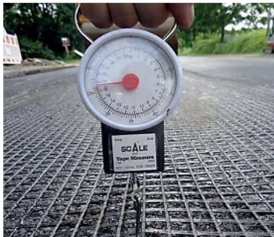
OBRÁZEK Č. 4 – PROVÁDĚNÍ ZKOUŠKY ADHEZE VÝZTUŽNÉ MŘÍŽE K PVRCHU VOZOVKY
