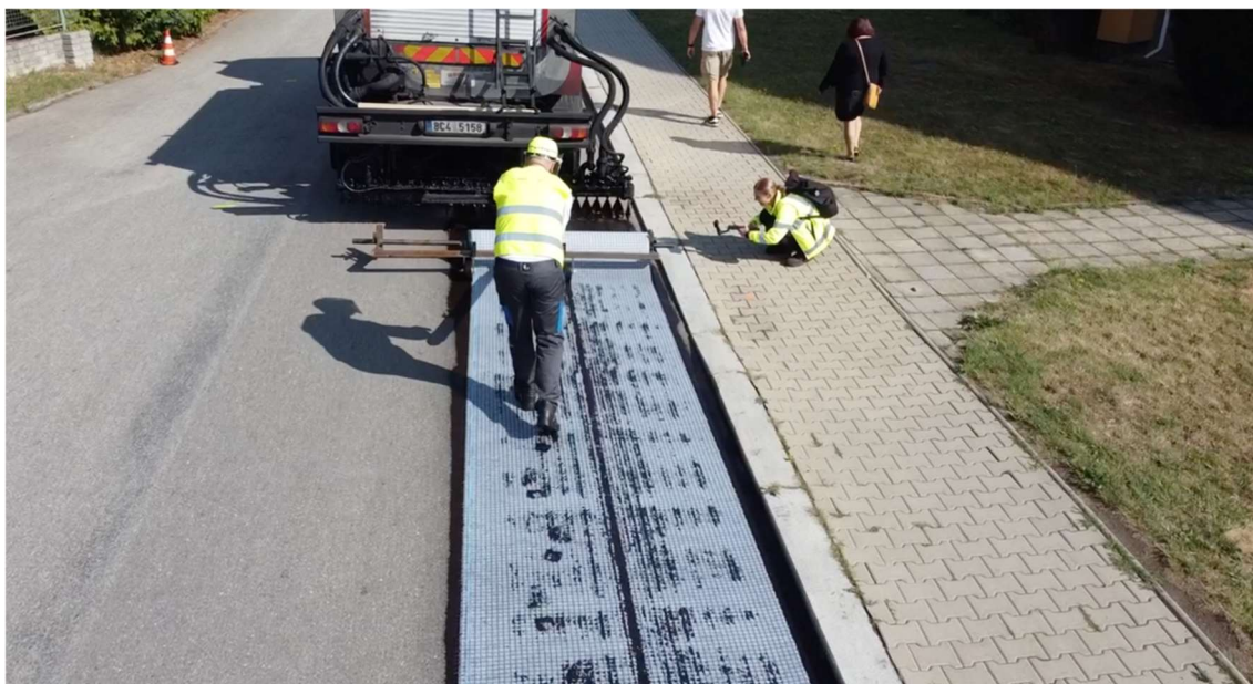
OBRÁZEK Č. 5 – APLIKACE SPOJOVACÍHO POSTŘIKU A POKLÁDKA KOMPOZITNÍ MŘÍŽE
