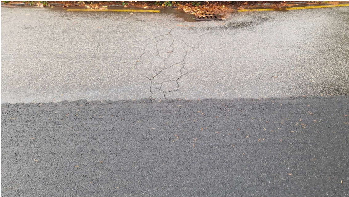
OBRÁZEK Č. 12 – ZAMEZENÍ ŠÍŘENÍ PORUCHY – VLIV KOMPOZITU (MŘÍŽE)
