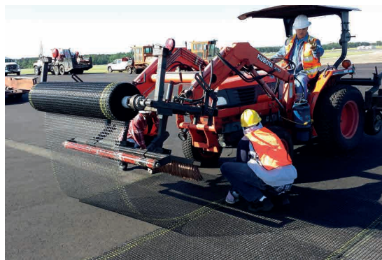
Pic. 3: Tracteur d'installation pour le ADFORS GlasGrid
