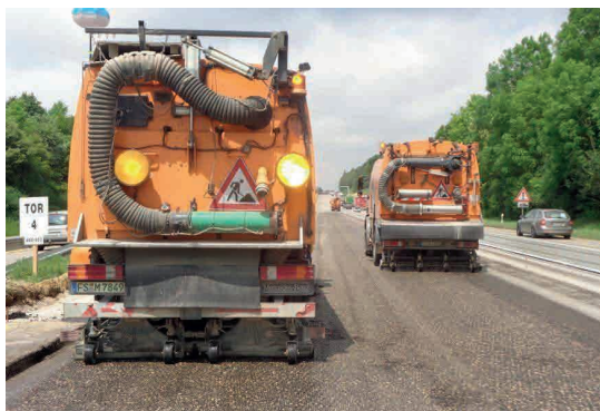
Pic. 1: Technologie ultra haute pression pour nettoyer la surface
