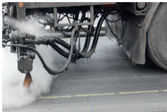
Pic. 8: Application de la couche d'accrochage sur le ADFORS GlasGrid GG
