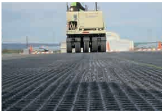
Pic. 2: Applications typiques et activation de la colle sur une couche de nivellement
