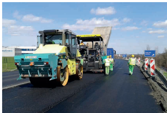
Pic. 9: Revêtement d'asphalte
