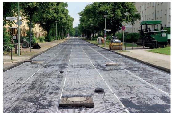
**Pic. 2:** Application typique du ADFORS GlasGrid CGL/CG sur une surface fraisée
