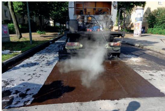
**Pic. 3:** Application de la couche d'accrochage avant installation du ADFORS GlasGrid
