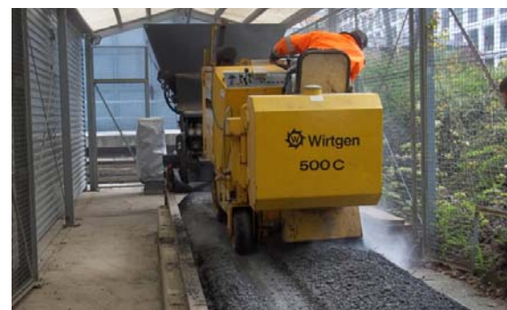
Bild 2: Fräsen des bewehrten Bereiches
