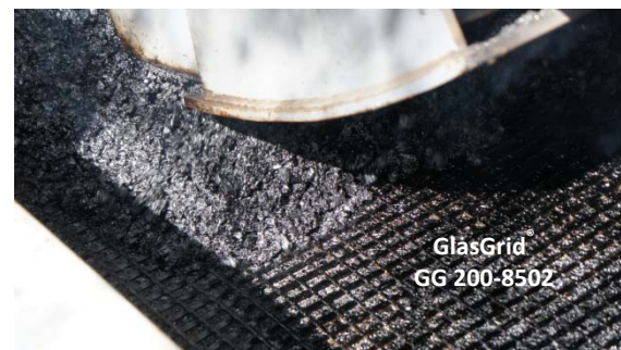
Bild 1: Überbauung des Bewehrungsgitters mit heißem Mischgut
