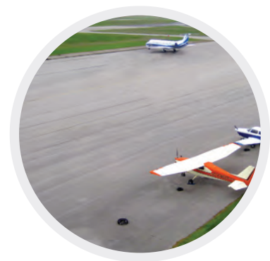
Zustand der reparierten Fläche nach 20 Jahren (Foto Mai 2012)
