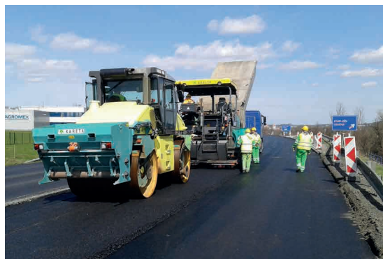
Obr. 9: Pokládka asfaltové vrstvy na mříž ADFORS GlasGrid TF
