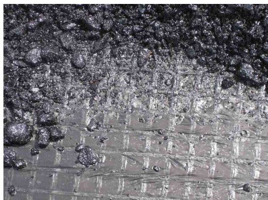
Obr. 7: Natavení filmu pro spojení vrstev
