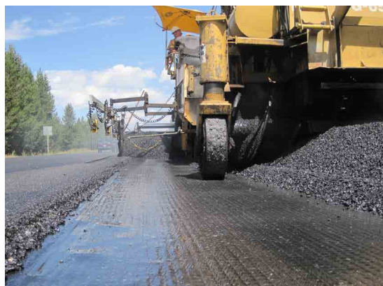
Obr. 8: Pokládka asfaltové vrstvy na mříž ADFORS GlasGrid TF
