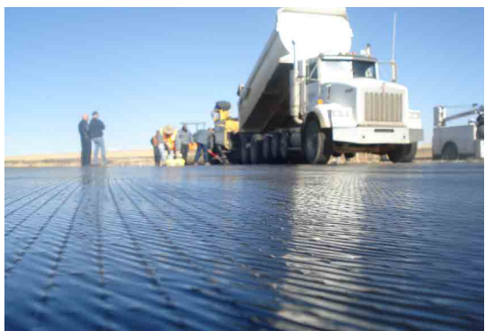
Obr. 1: Detail mříže ADFORS GlasGrid TF s filmem spojující vrstvy
