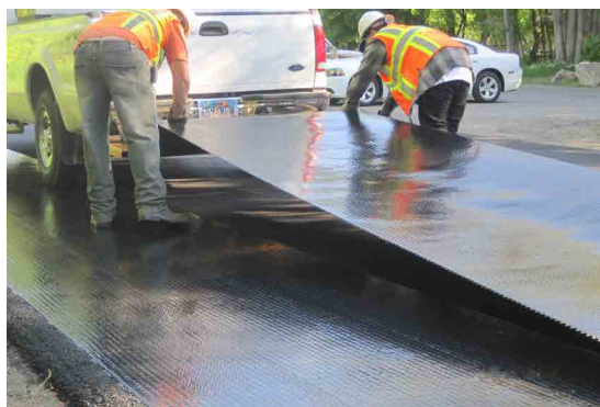
Obr. 2: Instalace mříže ADFORS GlasGrid TF
