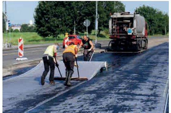
Obr. 5: Manuální instalace geokompozitu ADFORS GlasGrid CGL
