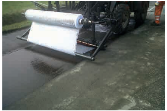
Obr. 4: Mechanická instalace geokompozitu ADFORS GlasGrid CGL
