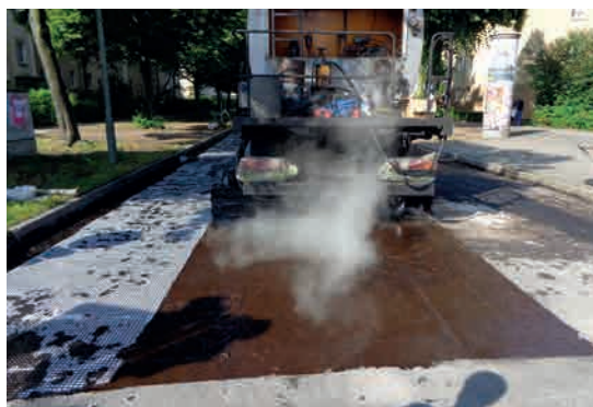
Obr. 3: Aplikace spojovacího postřiku před instalací geokompozitu ADFORS GlasGrid CGL
