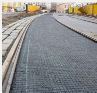
Installation d'ADFORS GlasGrid à Prague, 2013
