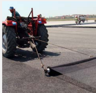
Installation d'ADFORS GlasGrid à l'aéroport d'Atatürk, 2010
