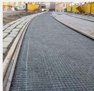
Einbau von ADFORS GlasGrid in Prag, 2013
